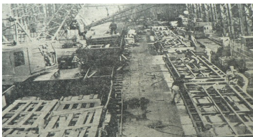
Vue d'une partie de la chaîne de montage
